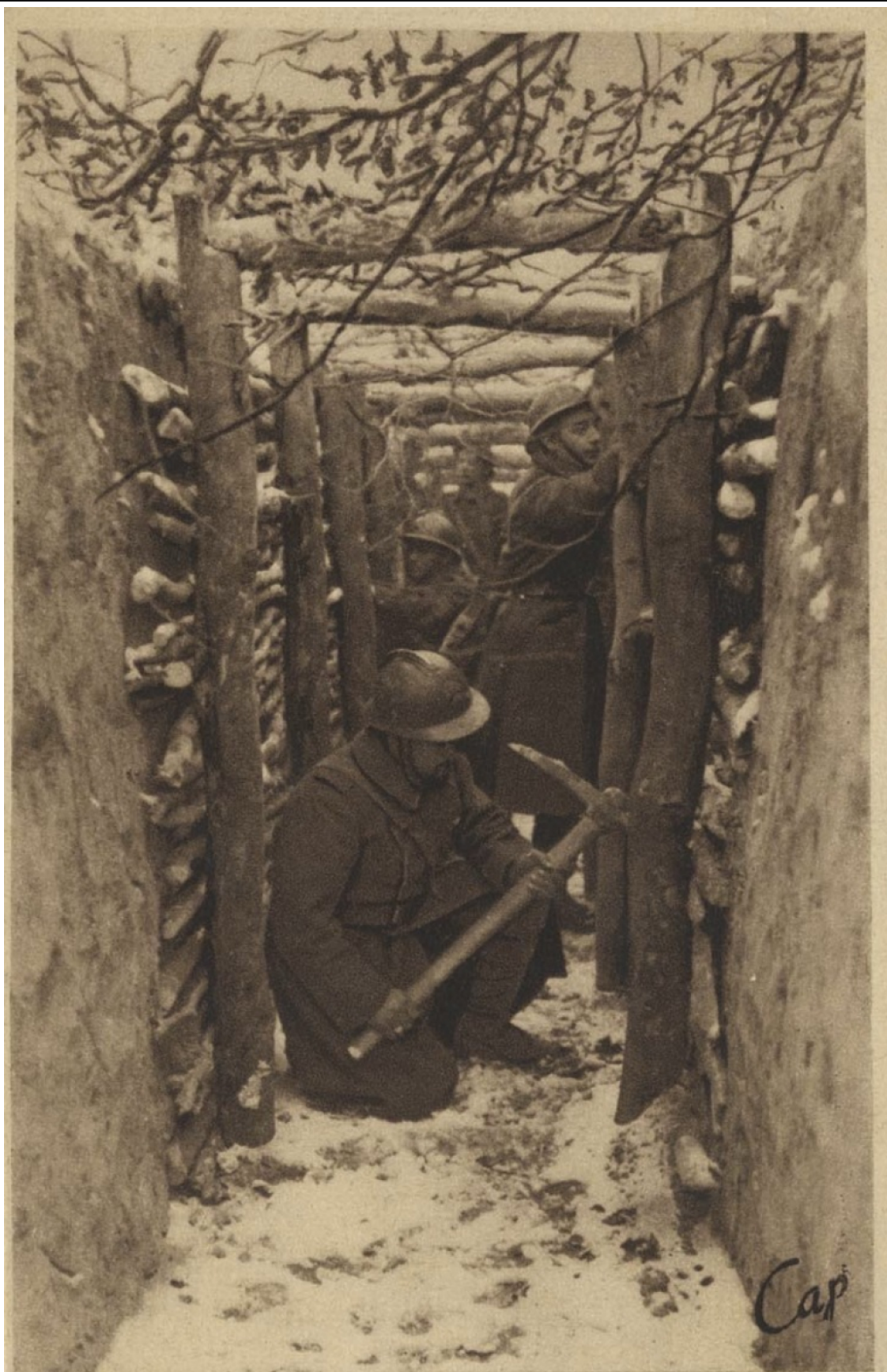
42 Sur le Front. - Aménagement d'une tranchée-abri
