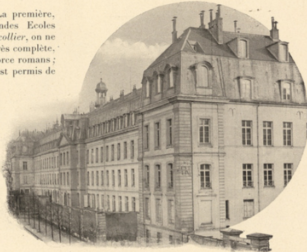
Vue Générale de l'Ecole.
