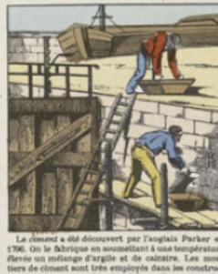
Le ciment a été découvert par l'anglais Parker en 1796. On le fabrique en soumettant à une température élevée un mélange d'argile et de calcaire. Les mortiers de ciment sont très employés dans la construction.
