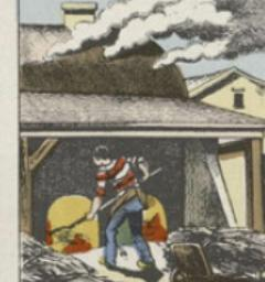
De même que la pierre à chaux, la pierre à plâtre est cuite dans des fours. Cette calcination, en la transformant en plâtre, la rend facilement éffrangible. On la réduit alors en poudre et on la mélange avec de la poudre pour fixer les éléments étrangers, le plâtre peut s'élargir en poussière impalpable. En cet état, comme il est très avide d'eau, il faut avoir soin de le préserver de l'humidité.
