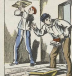
Le plâtre sert, en construction, à faire des murs lorsque la chaux est rare : partout des cloisons, des plafonds, des corniches et des meubles, des scelllements. A cet effet, on le mélange avec de l'eau et on le mélange à l'eau de façon à en faire une bouillie ou pâte plus ou moins épaisse. Cette pâte fait peur par évaporation de l'eau, et bientôt se solidifie quand celle-ci est complète, conservant toutes les formes qu'on a voulu lui donner.
