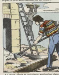
La chaux requiert sa principale application dans la construction des murs. A cet effet, on la mélange avec de l'eau et de l'argile pour former une pâte, la morte.
