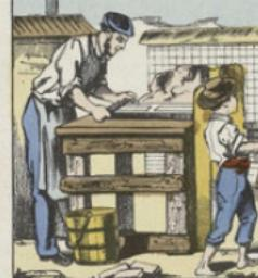
Les briques sont les premiers matériaux artificiels que l'homme ait fabriqués. Primitivement, on emploie des pierres plates et lisses, mais ce n'est pas assez bon pour plus tard que la cuve au four fut appliquée. La pâte qui serv à fabriquer les briques ou les tuiles est obtenue en mélangeant et pétissant ensemble de l'argile commune et du sable.
