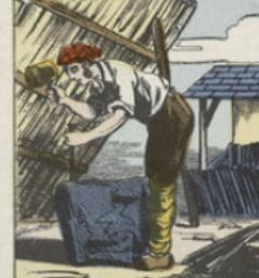
L'ardoise est une sorte de roche schisteuse, d'un gris bleuté plus ou moins foncé, qui présente la particularité de se diviser aisément par chose en feuilles minces. Elle est surtout employée pour les murs ou les toits. On la préfère pour la construction, et de remplacer la tuile pour la couverture des maisons. L'ardoise se juge bonne quand à la fois elle est de teinte foncée, pesante, dure et qu'elle ne fait pas l'eau. Les plus belles ardoises en France se trouvent près d'Angers.
