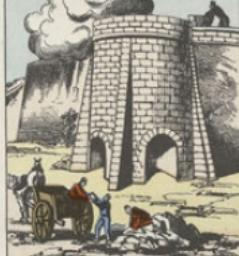
La chaux est obtenue par la calcination, c'est-à-dire par la chaleur, de diverses sortes de pierres à chaux.
