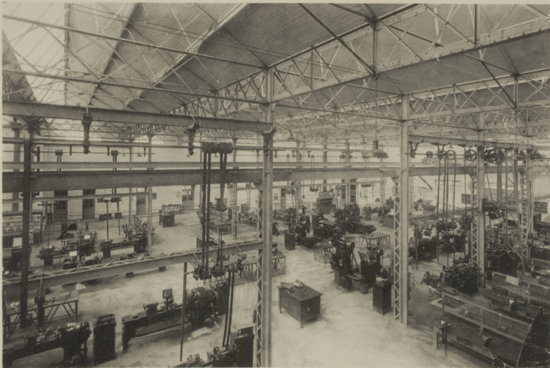
Atelier de Mécanique (11)
