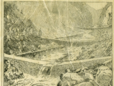
Fig. 3. — Barrages pour le reboisement.
