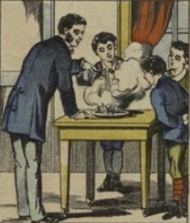
La CHAUX VIVE qui sort alors du four, possède la propriété d'absorber l'eau avec une grande violence. Si vous versez un peu d'eau sur un fragment de chaux vive, il FUVE, éclate en morceaux et s'échauffe tellement que l'eau se vaporise instantanément. C'est, du reste, une preuve de sa bonne cuisson et de sa bonne qualité.
