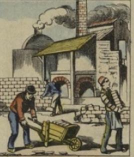
Quand la brique crue a été séchée au soleil, on la culte, pour lui donner la dureté, dans des fours où elle reste 20 ou 25 jours. La brique rougit, parceque l'argile contient du fer. Une bonne brique doit être sonore lorsqu'on la frappe et ne doit pas se laisser rayer avec une lame de couteau.
