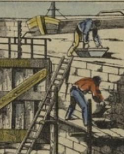
On appelle CIMENT un mortier spécial, découvert en 1815 par notre grand ingénieur français Vicat et qui possède la propriété de se durcir au contact de l'eau. On l'emploie pour les citernes, les écluses, les écluses, etc. Il se fabrique avec du sable et de la chaux argileuse qu'on appelle pour cela CHAUX HYDRAULIQUE.
