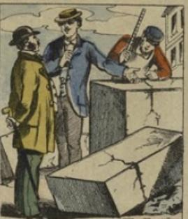
Il y a des pierres qui renferment de l'humidité naturelle, et qui, à cause de cela, éclatent et se fendent, lorsqu'il vient à gelée (d'où vient le proverbe: gelée à pierre fendre). Il faut bien se garder d'employer ces pierres dans la construction d'une maison. Aussi ne peut-on trop surveiller le choix de ses matériaux.
