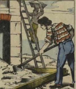
Si on verse de l'eau sur de la chaux, elle s'émet et se délaye entièrement, en formant une pâte ferme et épaisse. On mélange alors cette PATE ETEINTE avec du sable, et on brasse le tout avec un racloir. C'est ce qu'on appelle le MORTIER: c'est de la véritable pierre liquide.
