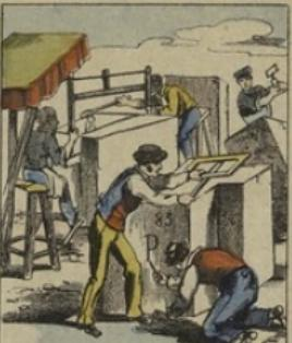
La pierre se scié et se taille généralement sur le chantier, de façon à pouvoir être expédiée toute prête pour la pose. Les deux surfaces horizontales qui forment le dessus et le dessous s'appellent les LITS de la pierre. Les côtés droits que l'on voit s'appellent les PAREMENTS.
