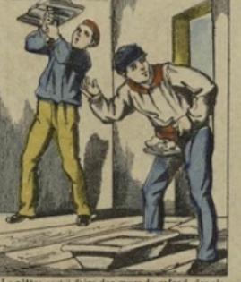
Le plâtre sert à faire des murs de refend, des plafonds, des corniches ou moulures, à sceller le fer dans la pierre, etc.: à cet effet, on le gâche dans une sauge avec un peu de sable de façon à en faire une bouillie, ou moins facile à manipuler. Cette pâte fait PRISE et bientôt se solidifie en conservant toutes les formes qu'on a voulu lui donner.
