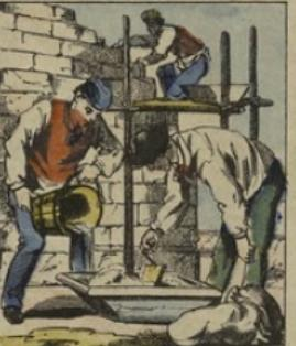
Le mortier prend avec sa truelle un peu de ce mortier et l'étende entre les pierres, les briques ou les moellons dont il fait son mur. Bienfond le mortier sec, et la chaux se combine avec l'acide carbonique de l'air pour reconstruire le carbonate de chaux, c'est-à-dire redevenant véritablement de la pierre.
