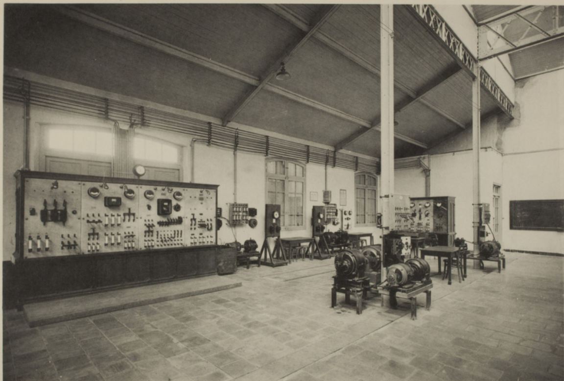
Un coin de l'Atelier d'Électricité (2)
