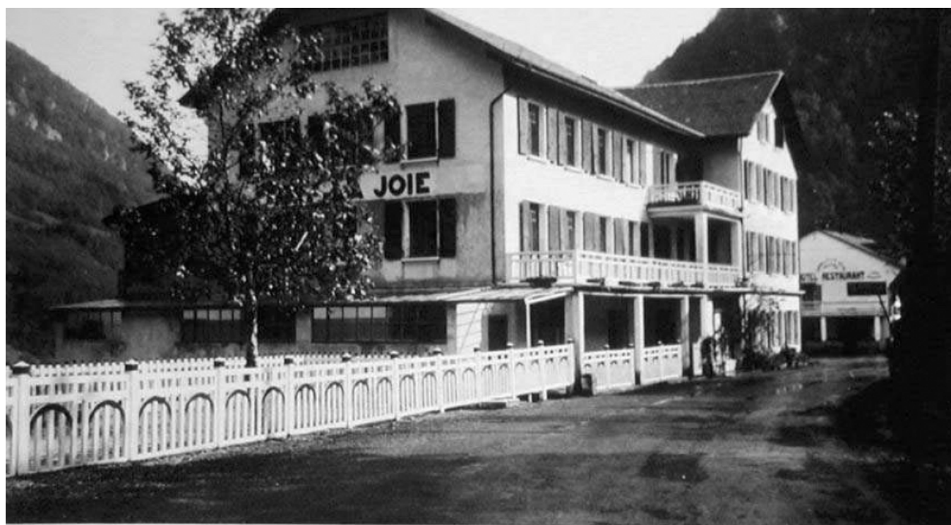
Préventorium "vers la joie" alt. 700 m.
