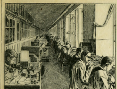
Fig. 7. — Les ateliers de remontage, c'est-à-dire d'assemblage des différentes pièces des montres, dans une fabrique moderne d'horlogerie.
