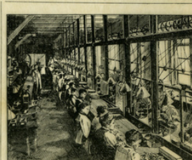
Fig. 6. — Ateliers de l'ébauche, c'est-à-dire de la préparation des différentes pièces des montres, dans une fabrique moderne d'horlogerie.
