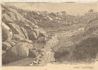
Roches de granit à gauche
