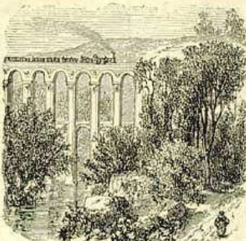
Chemin de fer passant sur un viaduc.
