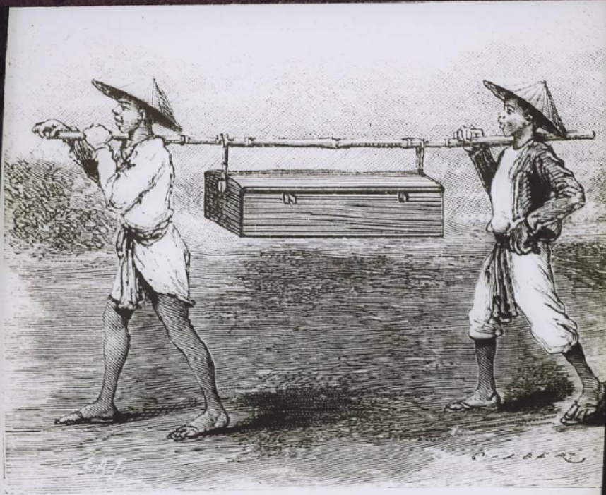
Transport d'une caisse de munitions d'artillerie par des Tonkinois
