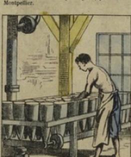
Afin de précipiter l'écoulement du sirop de clairage par le petit trou ménagé au bas de toutes les formes à pain de sucre, on les place sur un appareil nommé aspirateur, qui, à l'aide du vide opéré dans l'appareil, suce et aspire rapidement le sirop resté liquide; le sucre cristallisé peut sécher alors rapidement.
