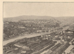
Les villes Lyon, le Saône et le coteau de Fourvières.
