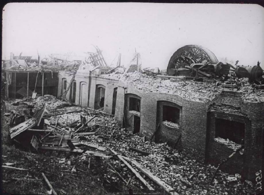
16. Pas-de-Palais-Aniche - fosse la Renaissance - machine d'extraction détruite par les Allemands.
