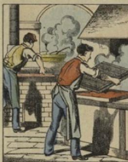
Cette PRESSE est alors plongée dans un bain de soufre liquide, puis passée sur une plaque recouverte d'une épaisse couche de pâte chimique phosphore. Les 5.500 allumettes se trouvent ainsi soufrées puis phosphorées d'un coup.
