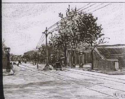
Vue d'un poteau supportant les fils.
