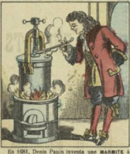
En 1684, Denis Papin inventa une MARMITE à cuire la viande et les os au moyen de la vapeur d'eau. Il réussit à cuire plusieurs choses en une fois en cuisant des viandes dans son DIGESTEUR, il y fit un trou qu'il boucha avec une soupe. Telle est l'origine de la célèbre soupe de sûreté des chaudières à vapeur.
