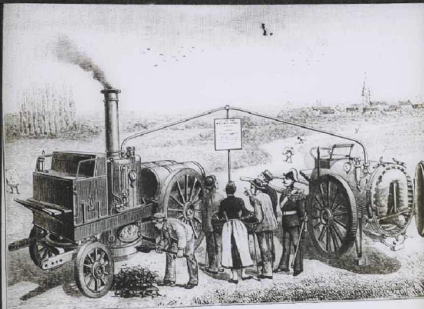
Train sanitaire de désinfection. — Ecuve locomobile et sa chaudière, pendant l'épidémie de suette miliaire en Pologne.
