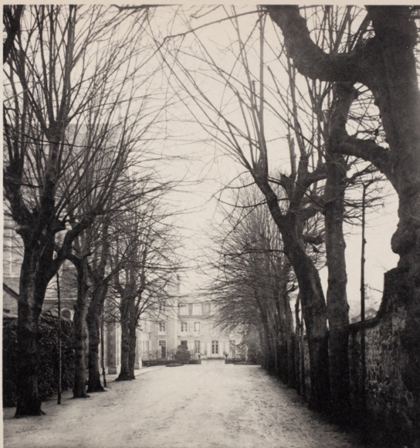
Entrée Grande Avenue 41
