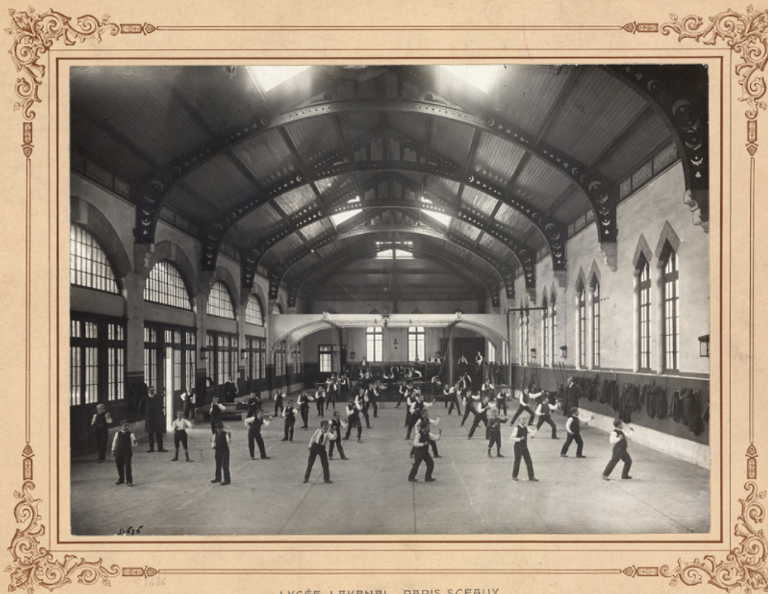
LYCÉE LAKANAL, PARIS-SCEAUX Salle de Gymnastique
