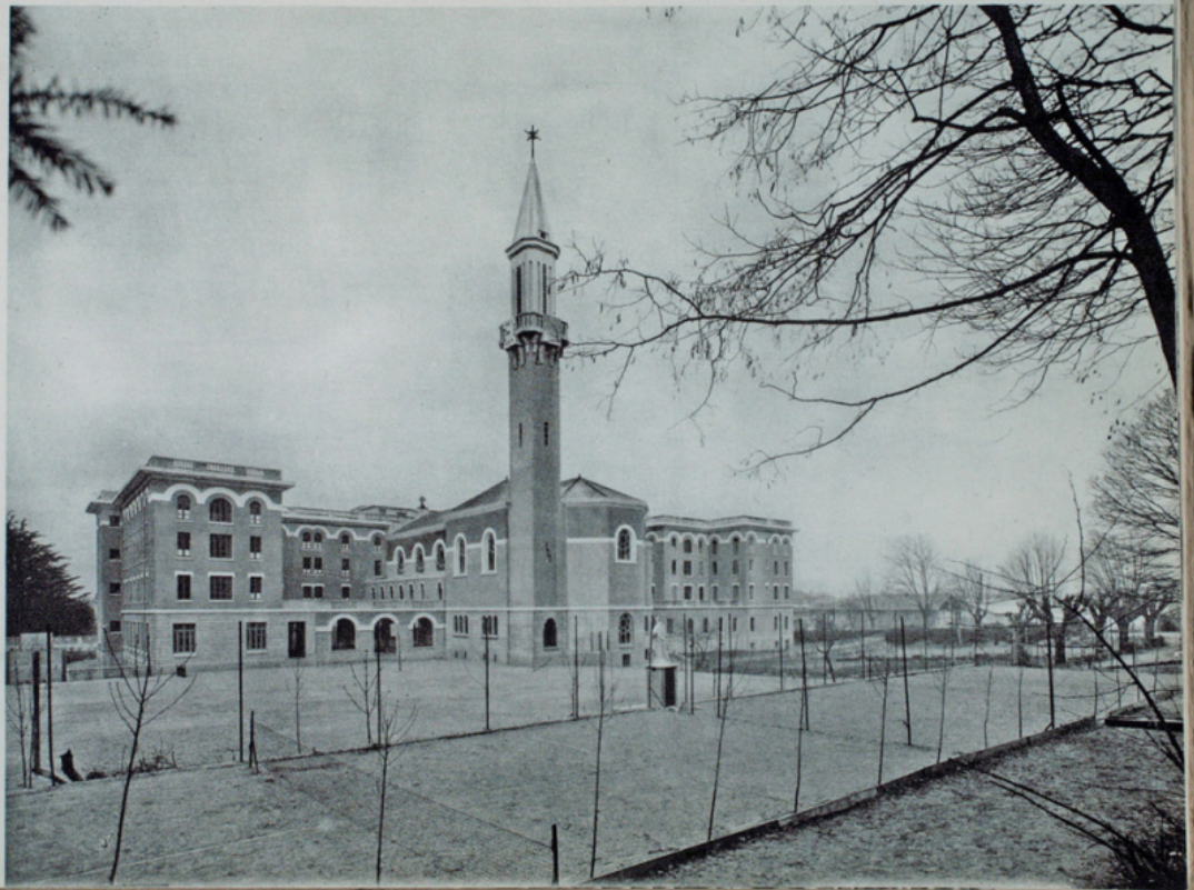
Cours de récréation et Séminaire vu du sud-est (7)
