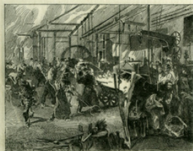
Fig. 10. — Usine Krupp à Essen : fonderie de l'acier.
