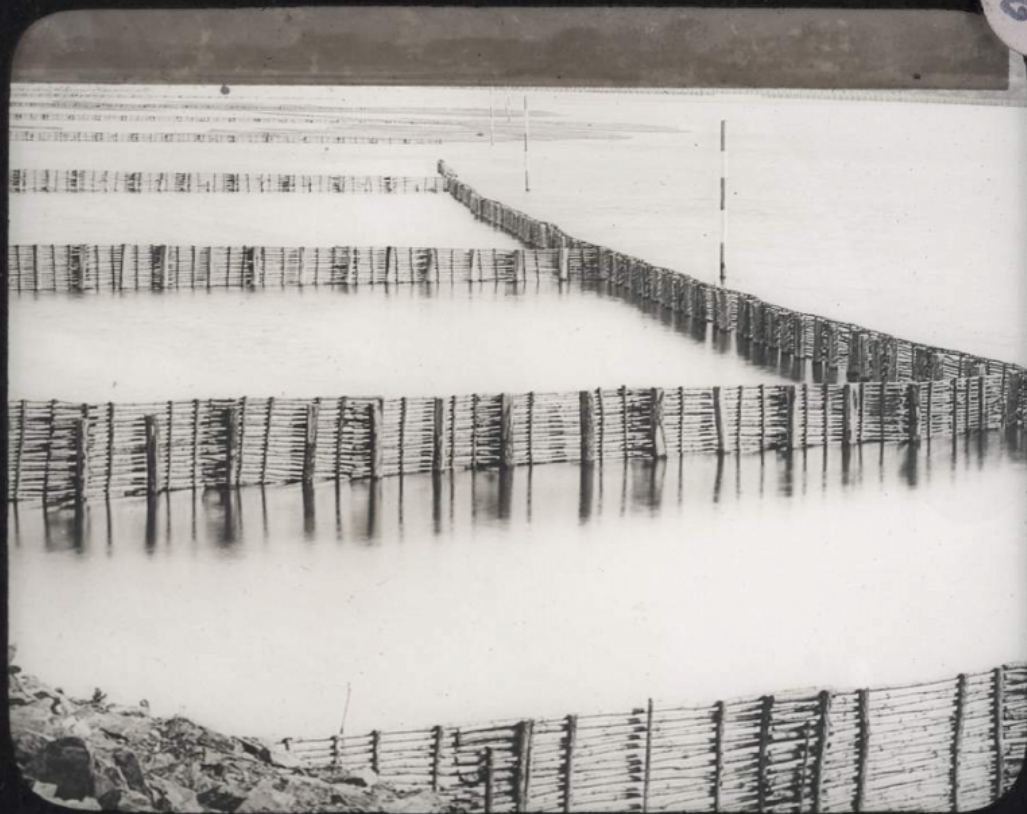
Savennières. Barrages de la Loire
