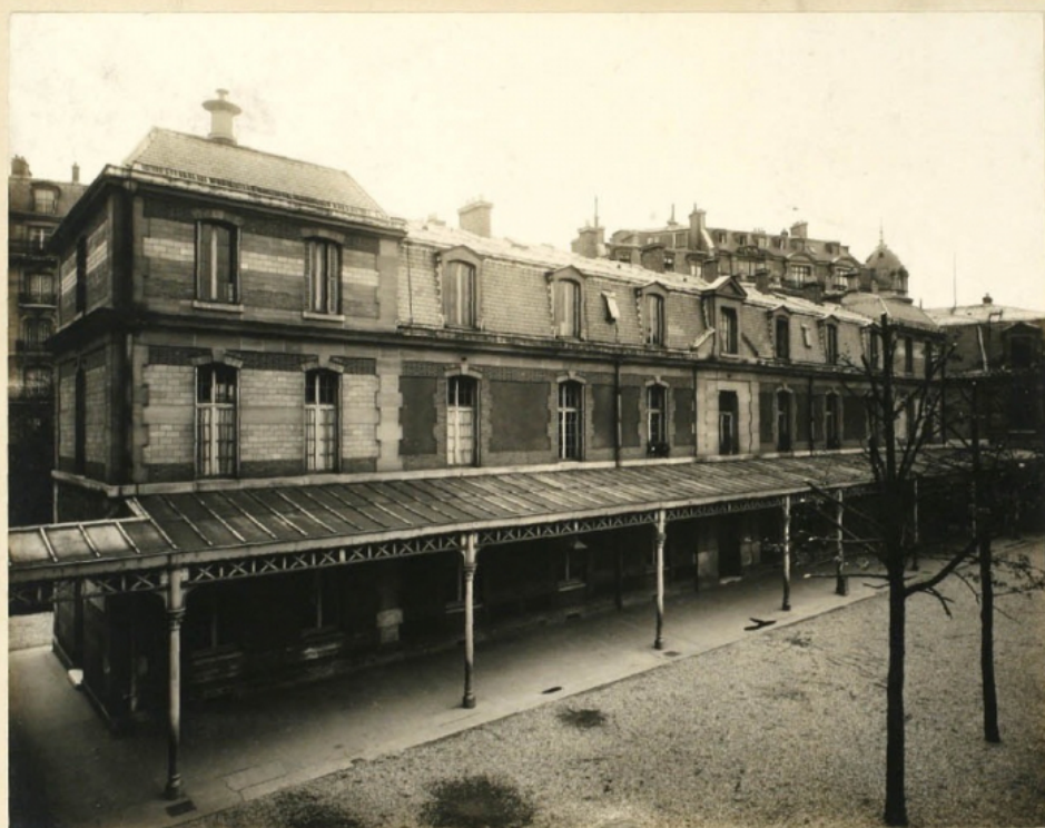
16 - Sanilhon de l'infirmerie
