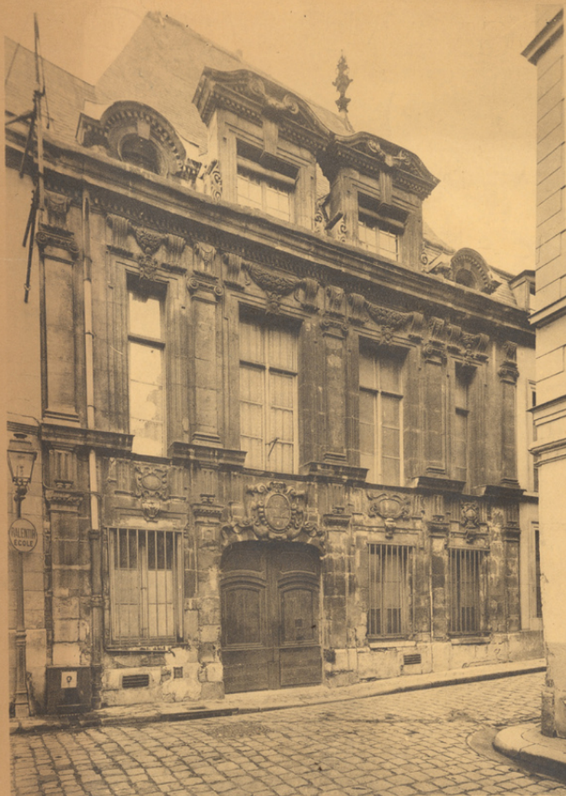
Façade XVII e siècle, rue Saint-Patrice.
