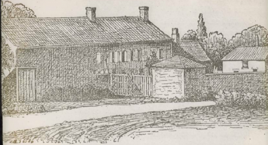
Fig. 1. — Maison de ferme à Saint-Hilaire (anton d'Avesnes).
