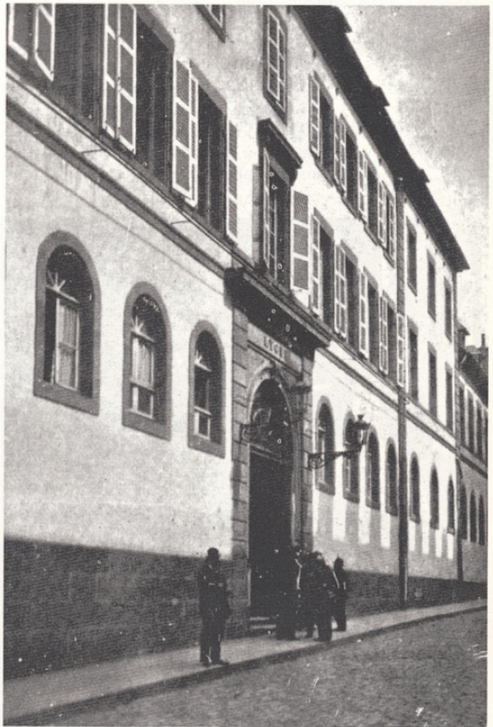
Porte d'entrée du Lycée
