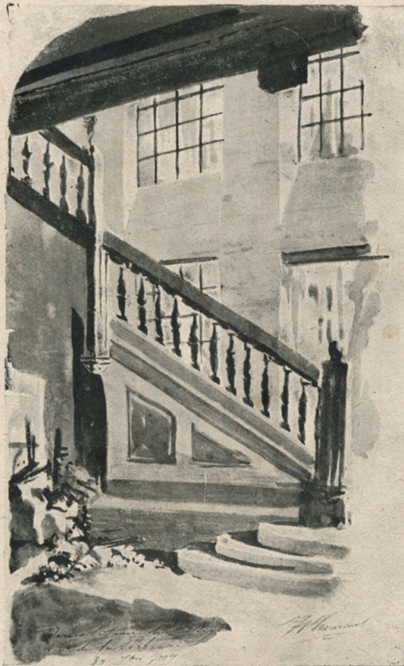
Fig. 26. — Escalier du Lycée, vu de la Sorbonne, pendant la démolition, en septembre 1887. (Dessin relevé de sépia.)
