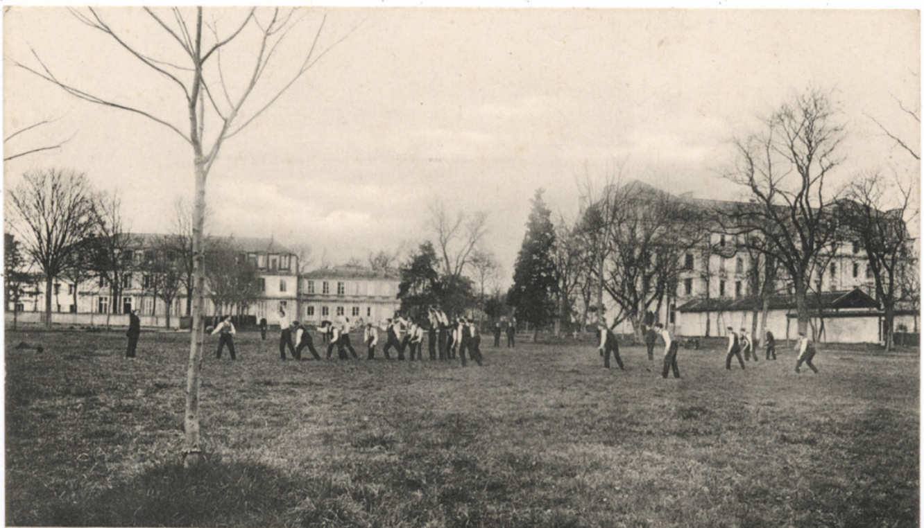
Ecole Ste-Marie (Grand Lebrun) - Caudéran-Bordeaux. - Vue d'Ensemble, prise du fond du Parc
