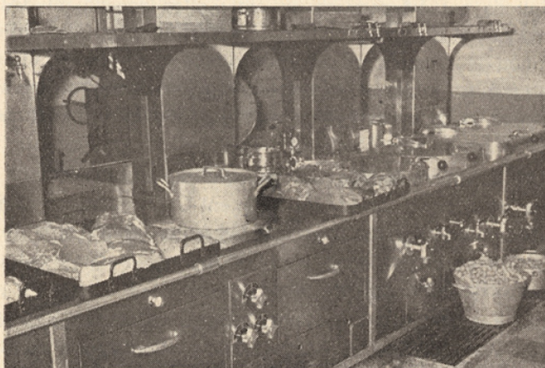
Installation récente de la cuisine
