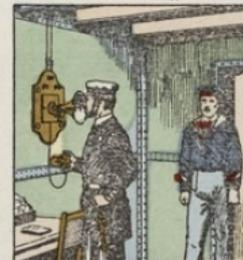
**Téléphone haut-parleur.** En employant un microphone spécial, il est devenu possible de donner au téléphone une puissance supérieure à celle de la voix humaine. Nous signalerons le système Gaillard-Ducrot employé sur les navires de guerre pour remplacer les tuyaux acoustiques et les porte-voix.
