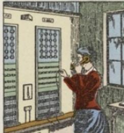
Dès 1876, des communications téléphoniques filaires furent installées avec ce téléphone magnétique. Mais, en pratique, sa portée se trouva restreinte à quelques kilomètres, à raison de la présence de courants anormaux sur les fils conducteurs.
