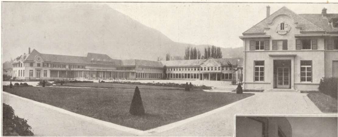
Le développement « linéaire » des bâtiments de l'école professionnelle de Vizille, près de Grenoble. MM. Robert Fournet et Louis Sainsaulieu, architectes.
