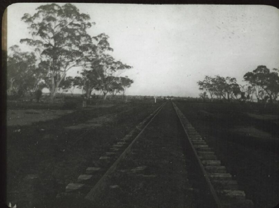
Ligne de chemin de fer dans la prairie (ligne Sydney-Bourke)
