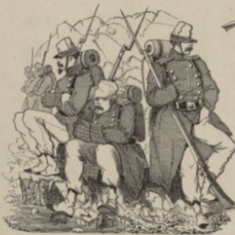
Garde de Tranchée.
