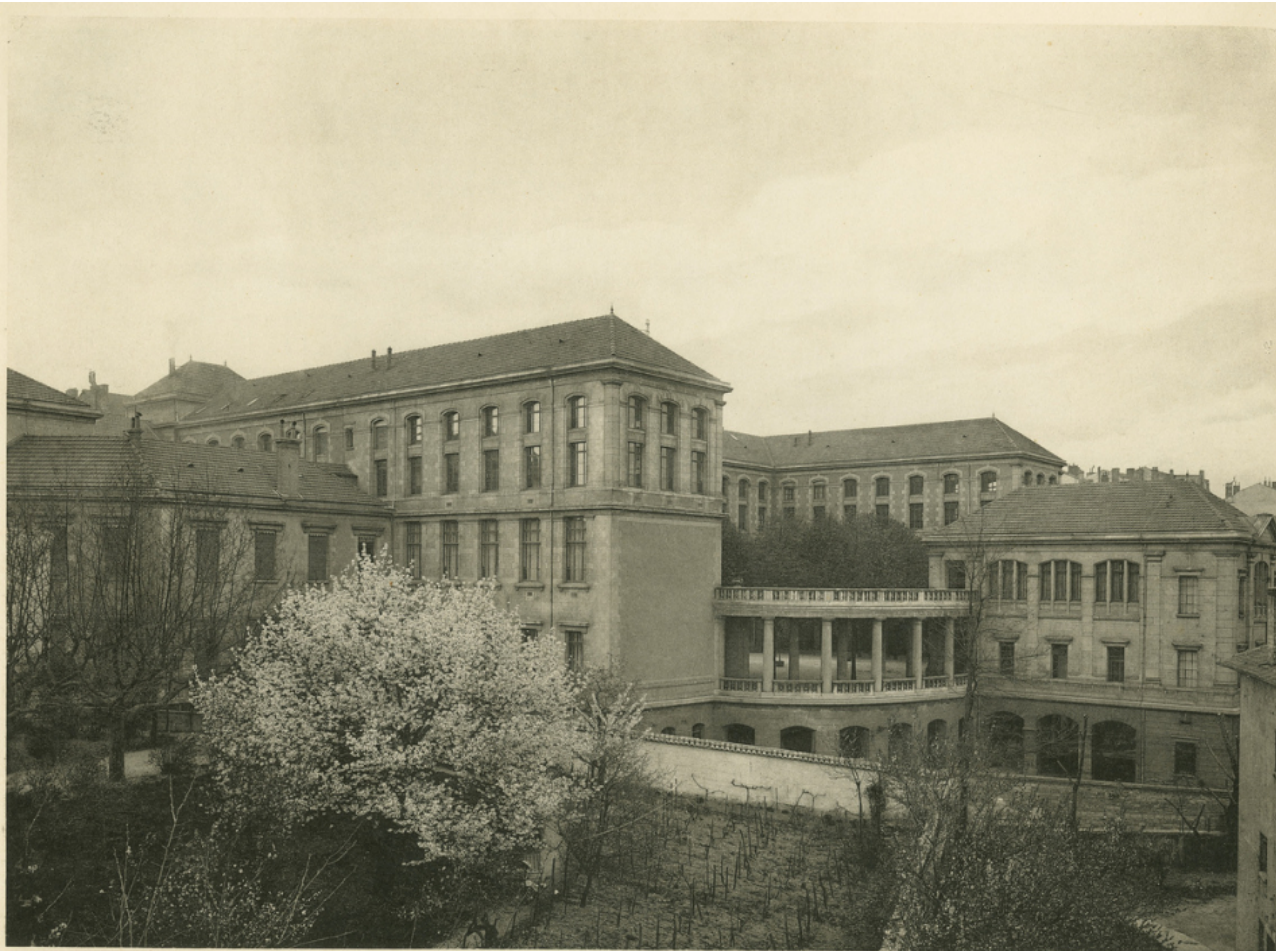
Vue d'ensemble, côté Sud
