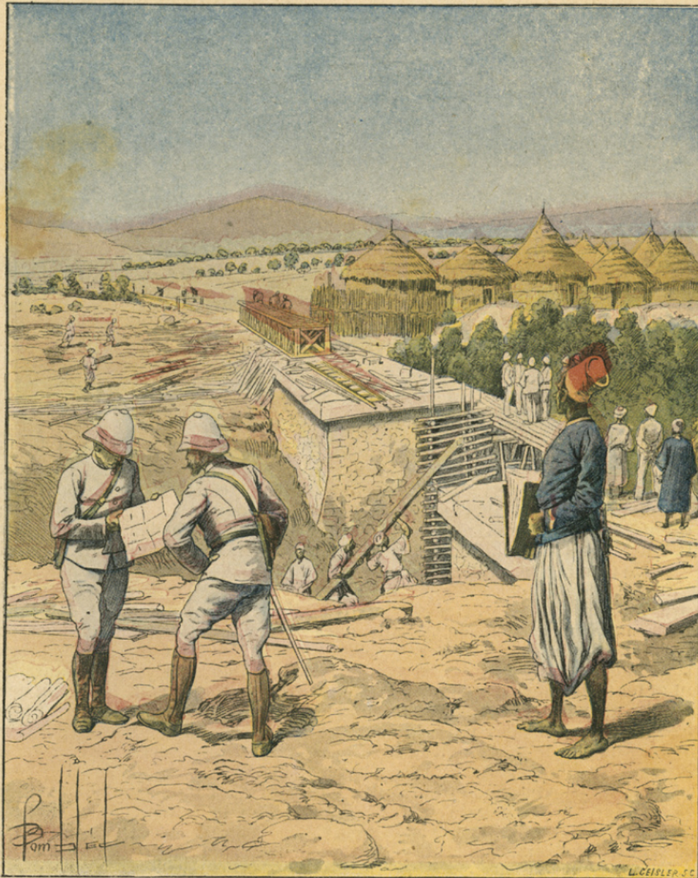
9. — Construction du Chemin de fer de Médine à Bafoulabé.
