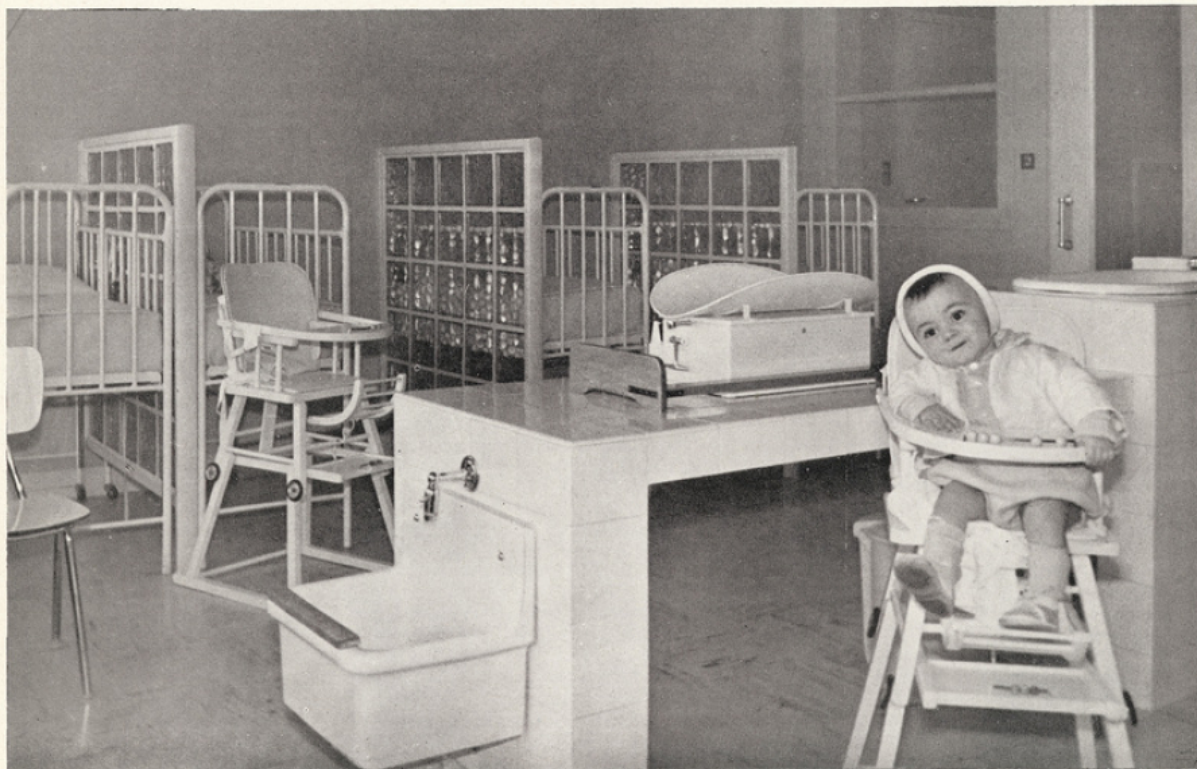
Les dortoirs sont séparés les uns des autres par des cloisons vitrées en partie haute de façon à faciliter la surveillance de l'ensemble. Toute la partie vitrée extérieure est traitée en briques translucides de Saint-Gobain. Le sol est en dalles plastiques Dalflex. Les enfants sont baignés, pesés et changés dans les dortoirs pour éviter les risques de refroidissement par déplacements dans les couloirs. Ci-dessous, on remarquera aussi le système de cloisons mi-hautes isolant chaque lit.
