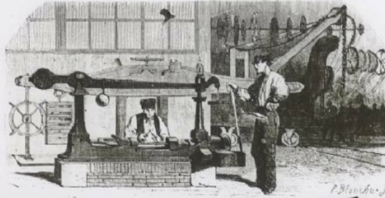
Machine à éprouver la résistance des câbles.
