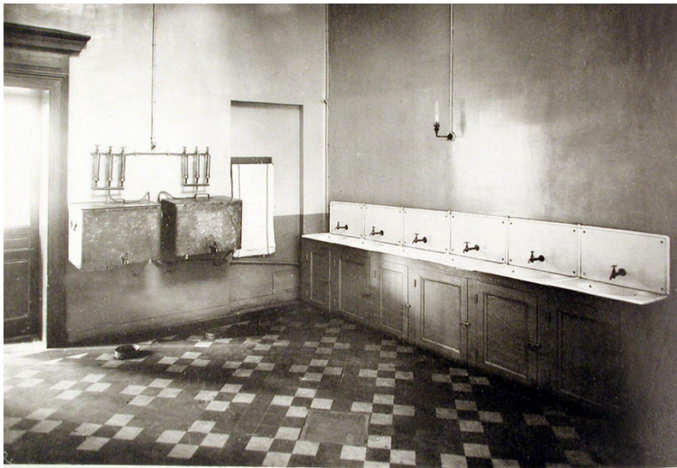
Vestibule du Réfectoire. - Lavabos et Filtres
