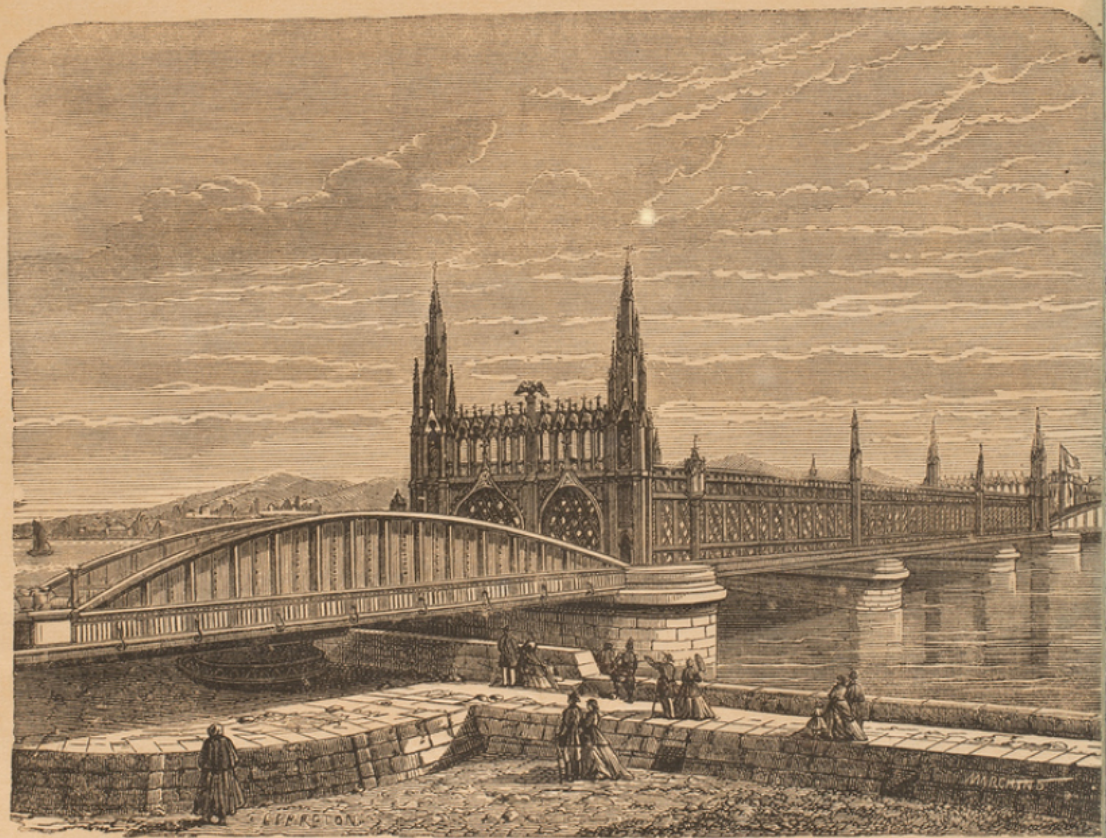
PONT SUR LE RHIN, entre Strasbourg et Kehl.
