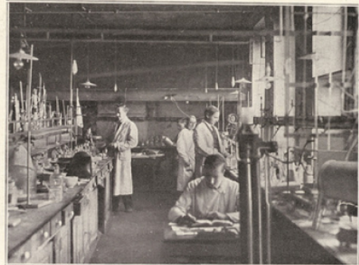
L'un des laboratoires de chimie minérale installé dans les locaux vétustes qui viennent de disparaître.
