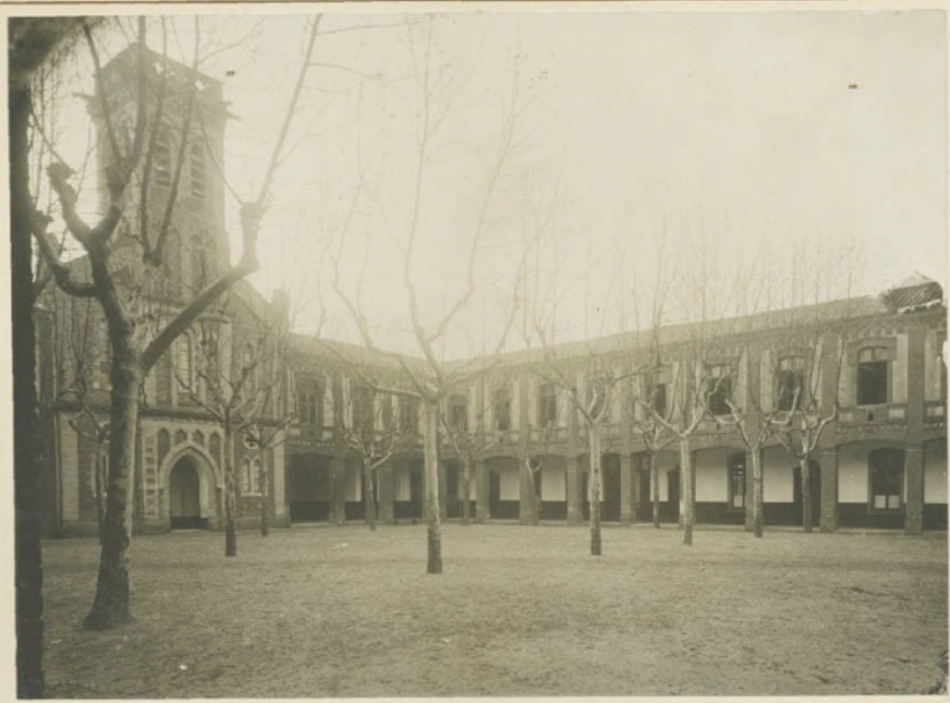
LYCÉE INGRES, MONTAUBAN
