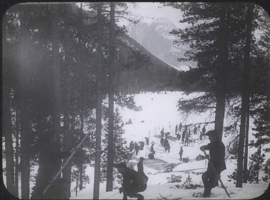
№ 19 - Installation d'un bivouac, abattage des arbres.
