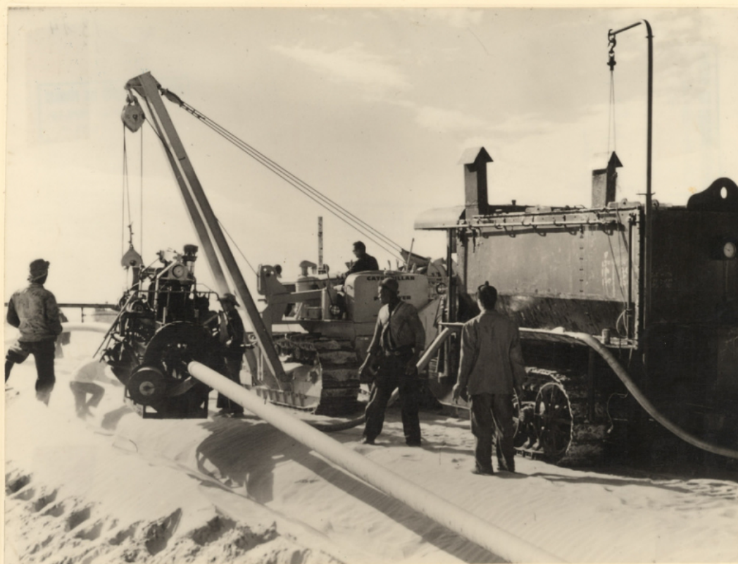
Pose d'un petit pipe-line( enrobé de papier) Dunes de DOKKARRE - SAHARA Octobre 1957 - Photo CFP
