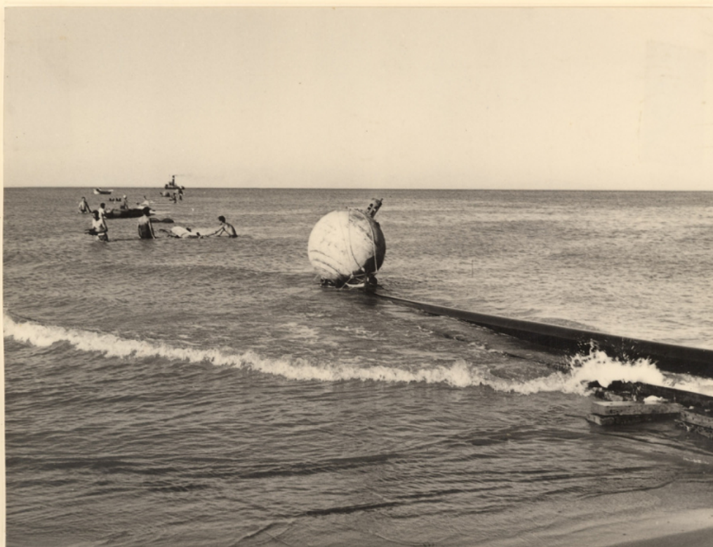
Chantier du Djebel Diss (Septembre 1960) Essais de pose d'un gazoduc sous-marin sur la côte algérienne . La canalisation, tirée par le remorqueur que l'on distingue dans le fond, et équipée de flotteurs "primaires" tels que bouées et bidons qui assureront sa flottaison jusqu'au point d'immersion, entre dans la mer.
