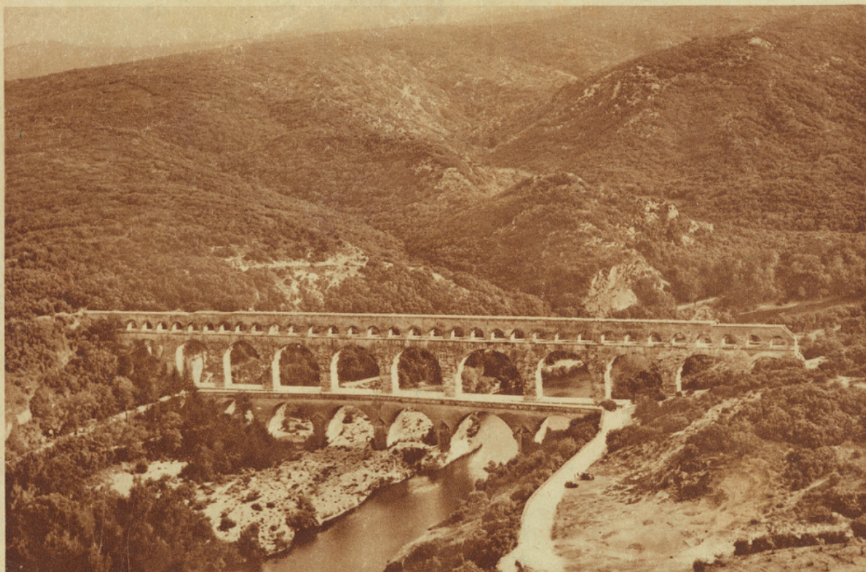
Gard. Vue aérienne du Pont.
