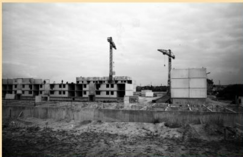
Construction des immeubles de la cité Marcelin-Berthelot
