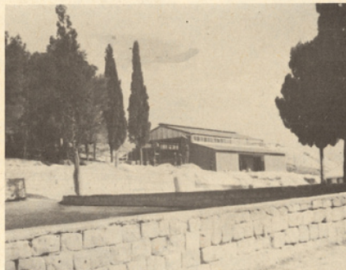
Atelier de soudure - Welding shop
