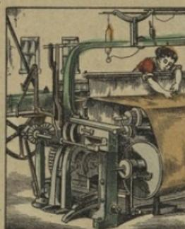
Le fil sert à former le Tissu du drap : on enroule des fils en longueur sur l'enrouleur du métier à tisser, ce qui forme la chaîne. Le tisserand, avec la navette, fait passer les fils en largeur, ce qui forme la trame.
